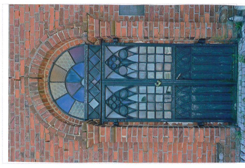
Fot. 5. Portal wejściowy i drzwi metalowe prowadzące do kaplicy, 2019.
